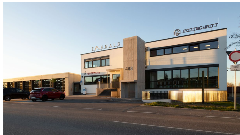
Feuerwehr Schömburg. Umnutzung und Anbau. Quelle: Bernd Mattern Architektur, Wellendingen
