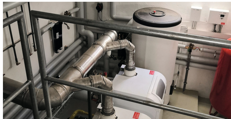
Sanierung der Wärmeerzeugung in einem Mehrfamilienhaus in Ludwigshafen
