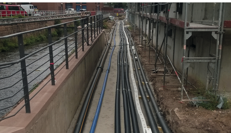
Hausanschlussleitungen
