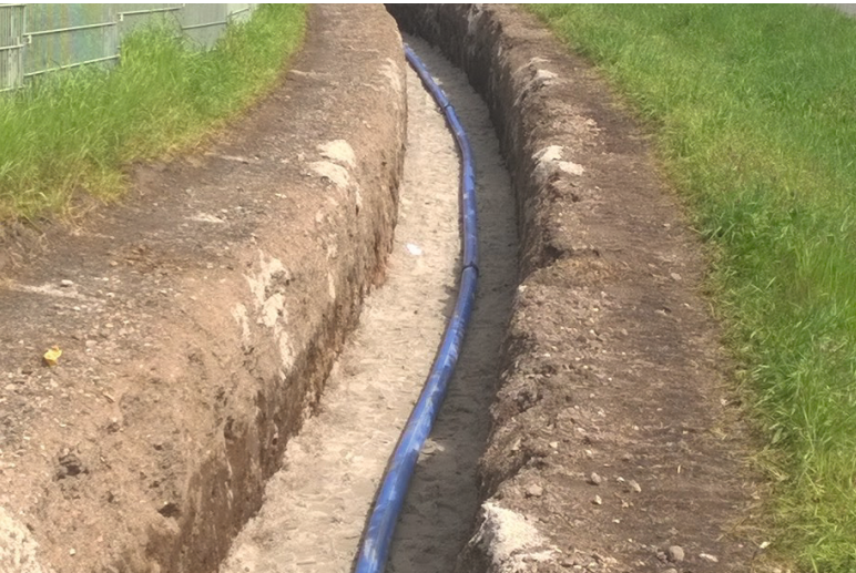
Neuverlegung Wasserleitung
