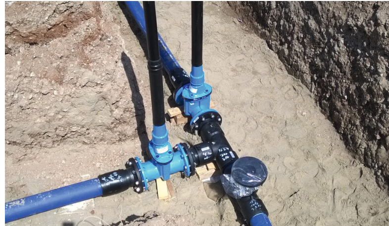
Erneuerung Schieberkreuz Wasser
