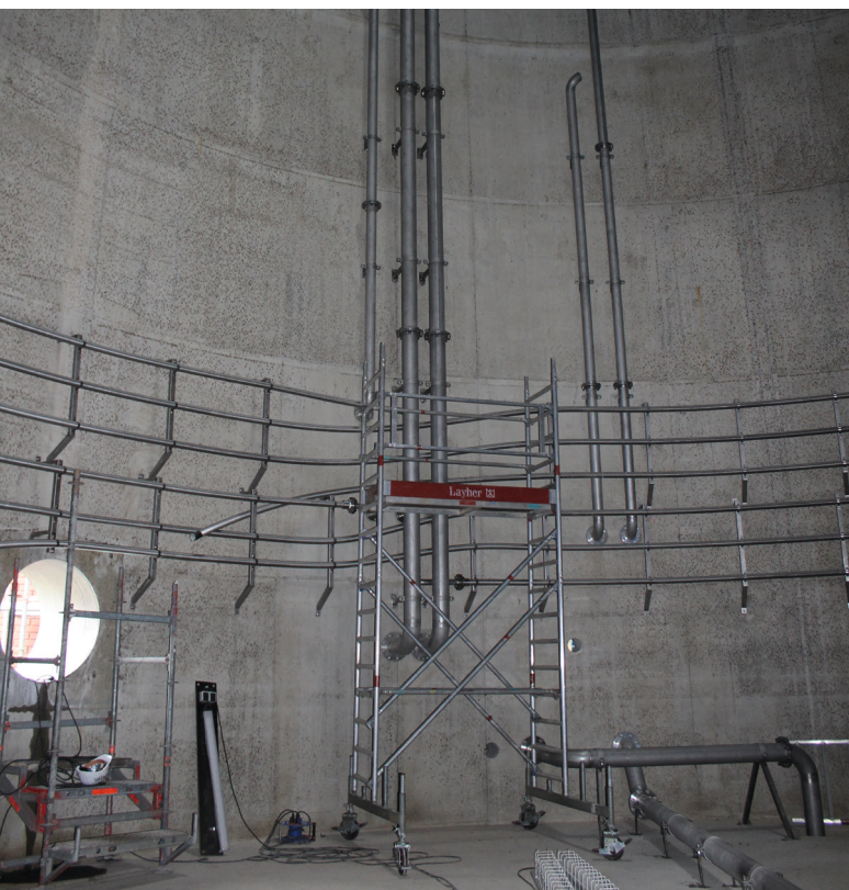
Innenansicht Faulbehälter bei der Montage der maschinellen Ausrüstung
