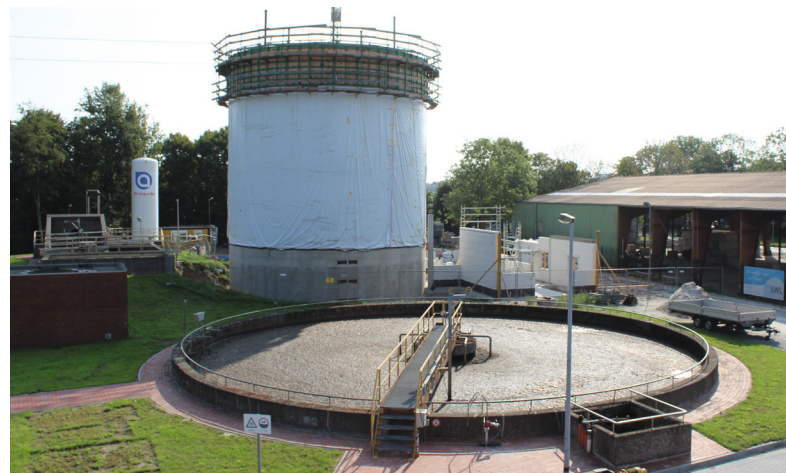
Betoniervorgang der Wände des Faulturmes ist abgeschlossen
