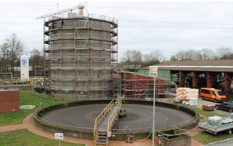
Eingerüsteter Faulturm zur Vorbereitung der Verkleidung
