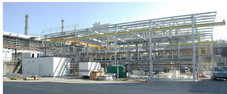
Neubau eines Apparategerüsts für Sammelgasverdichter in Marl
