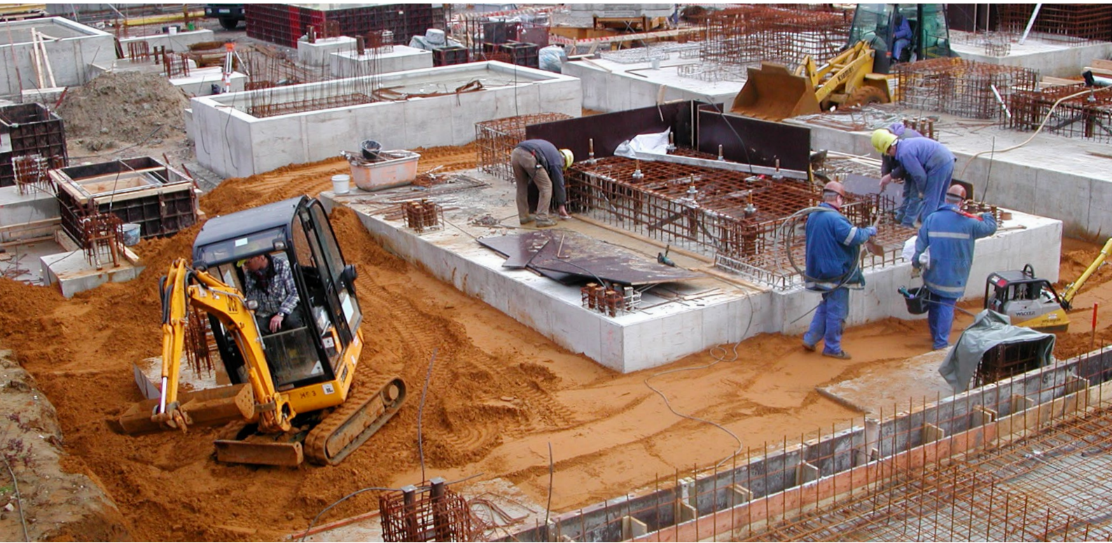
Arbeiten auf engstem Raum für die Erstellung von Turbinenfundamenten in Marl
