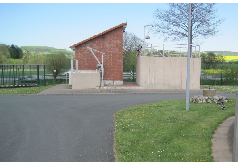
Pumpwerk Erneuerung technische Ausrüstung
