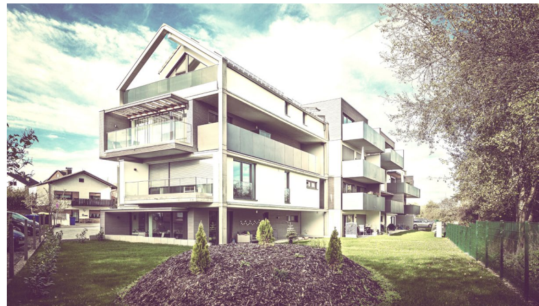
Neubau Mehrfamilienhaus (Foto), Wettengel
