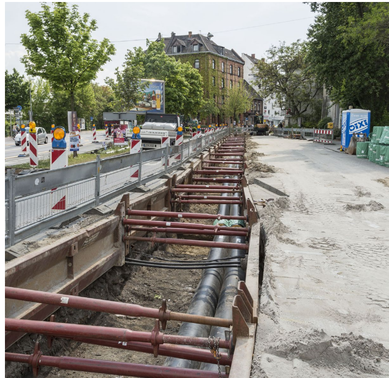
Verlegung der Fernwärmetrasse „Ringschluss – Süd“
