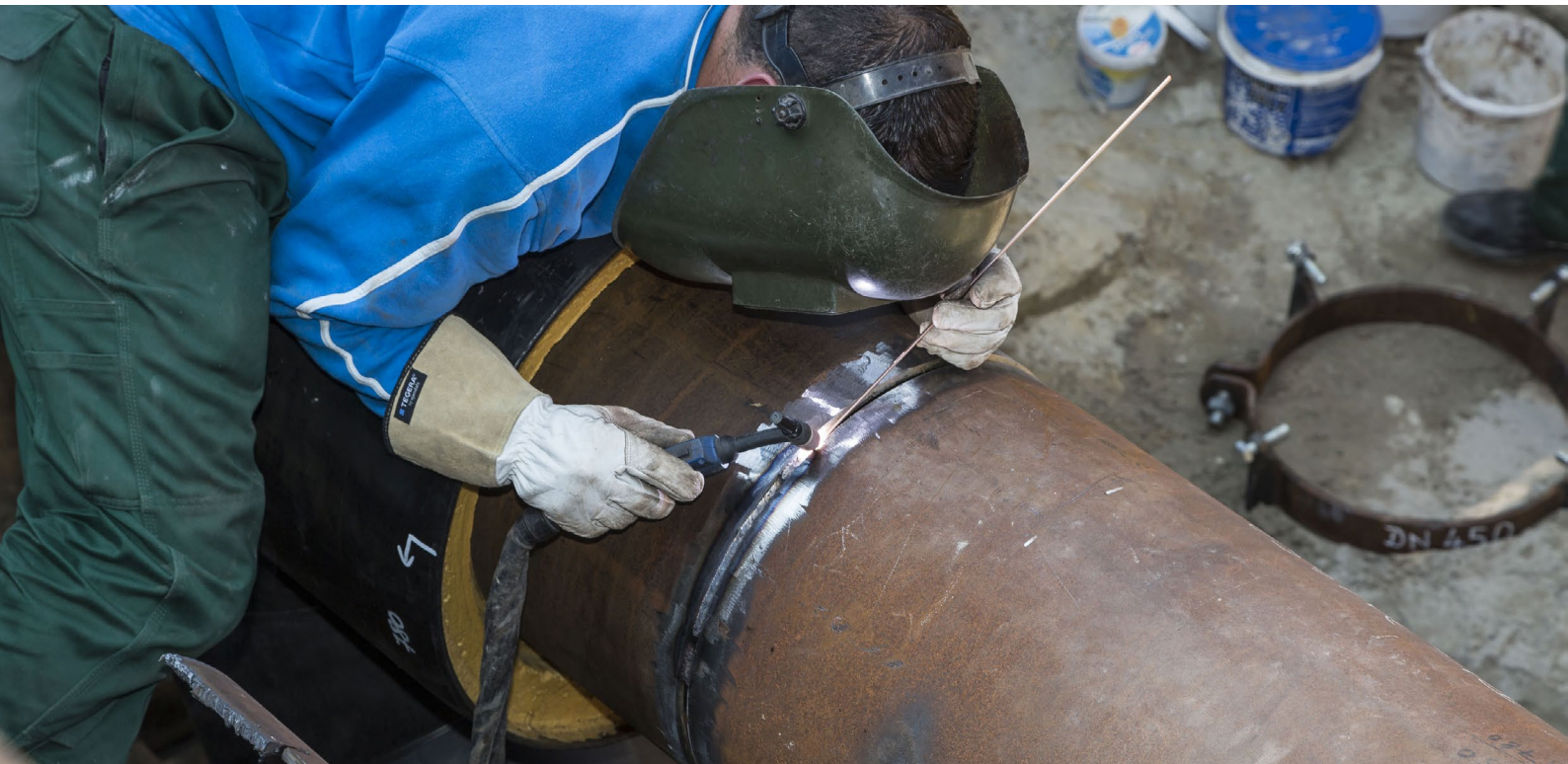
Schweißen einer Fernwärmeleitung
