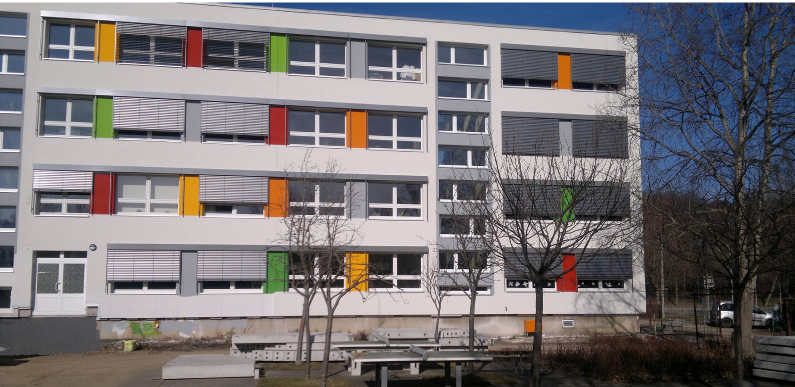
Modernisierung und Sanierung der Sekundarschule Thale
