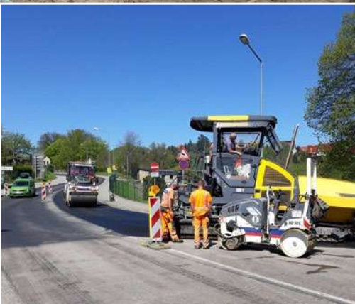
Freital: Fahrbahnerneuerung der S 36.
