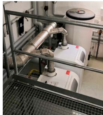
Sanierung der Wärmeerzeugung in einem Mehrfamilienhaus in Ludwigshafen
